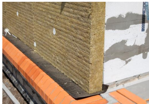
Isolation par l'extérieur avec de la laine de roche
